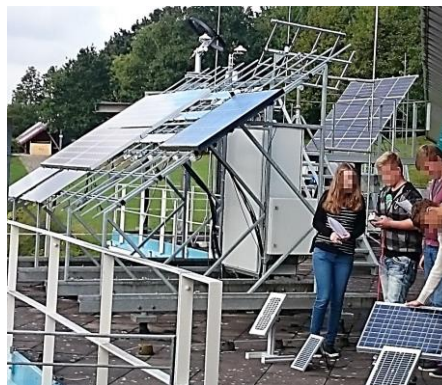
Experimente mit Solarmodulen auf dem Dach des ISFH
